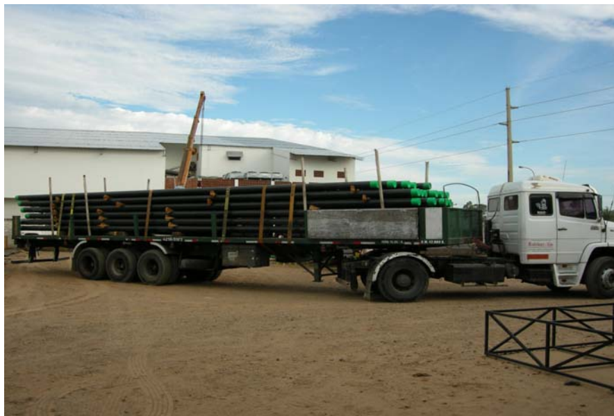
Foto: Traslado de las Tuberías para el gasoducto
