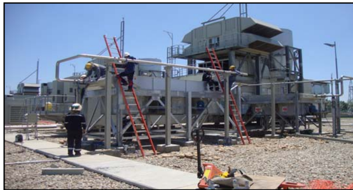
Foto N° 1: Trabajos de Mantenimiento Unidad ERI-02
