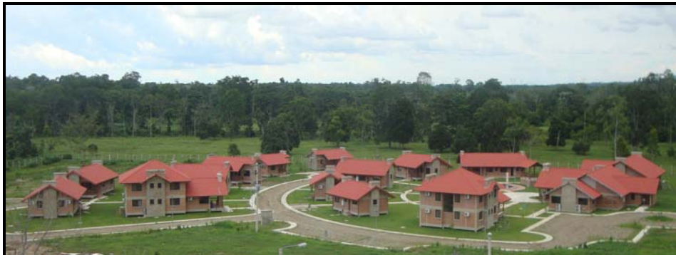
Foto N° 3: Vista del área residencial – Entre Ríos
