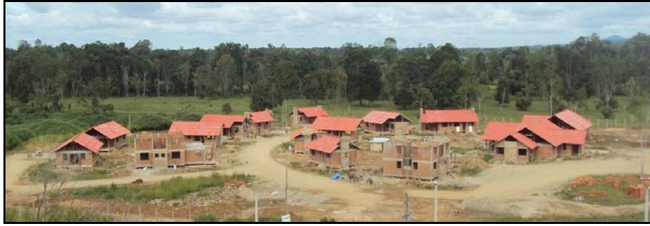
Foto N° 2: Construcción del área residencial
